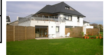
Façade arrière « Résidences Océanes »
